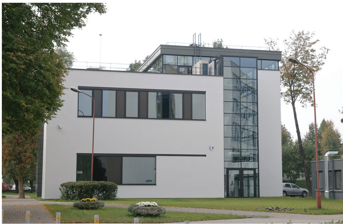
6.1 pav. Rekonstruotas Maisto mokslo ir technologijų centro pastatas
