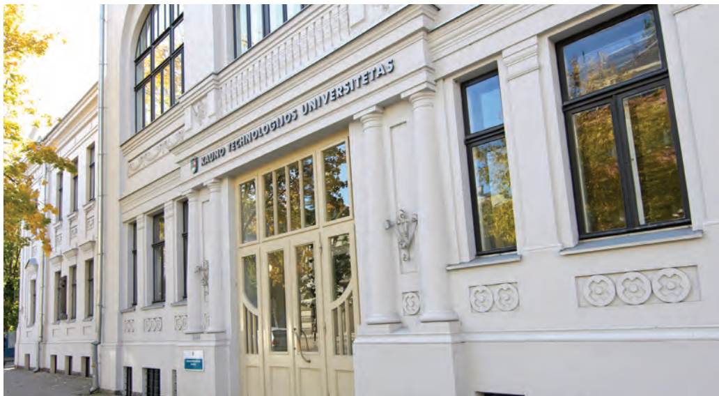
► I rūmų fasado renovavimas
